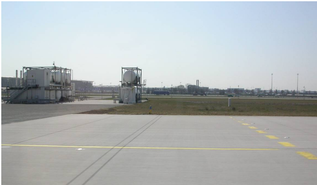
Granja de tanques existente de líquidos de deshielo
